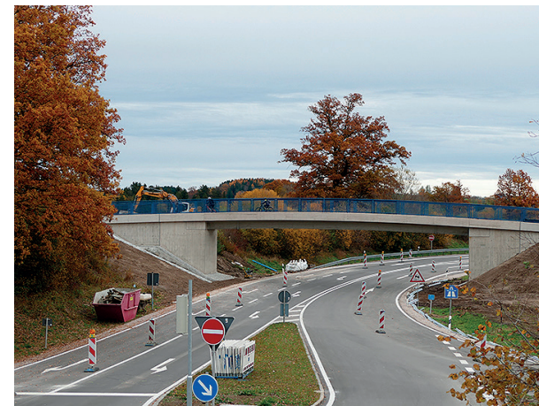
Fast fertig: Der neue Radwegabschnitt zwischen See und Graben führt über die A980-Anschlussstelle Durach.
