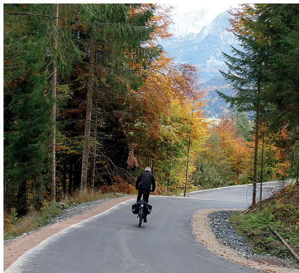
Die bis zu 20% steile Zufahrt ins Bolgental wurde ebenfalls mit frischem Asphalt versehen.
