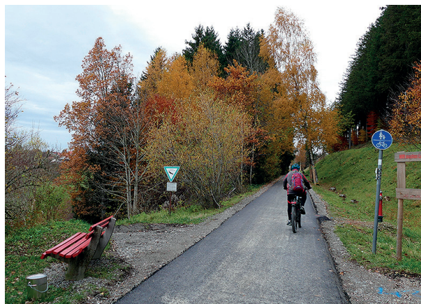
Der größte Teil des 2,2 Kilometer langen Abschnitts zwischen Ahegg und Ermengerst ist bereits fertig asphaltiert.
