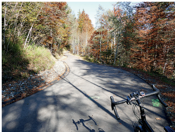
Frisch sanierter Abschnitt des Königssträßchens: hier war teilweise der Hang in die Starzlach abgerutscht.
