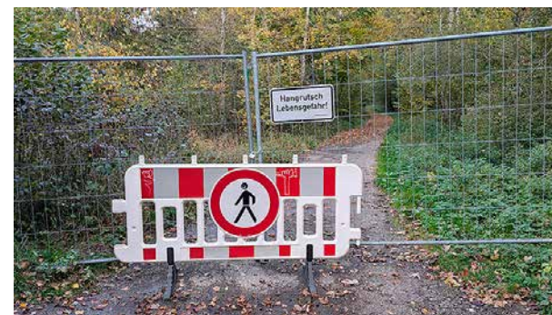
Wegen eines Hangrutsches gesperrt: der Radweg an der Rottach verbindet den Haubensteig mit dem Kemptener Norden.
