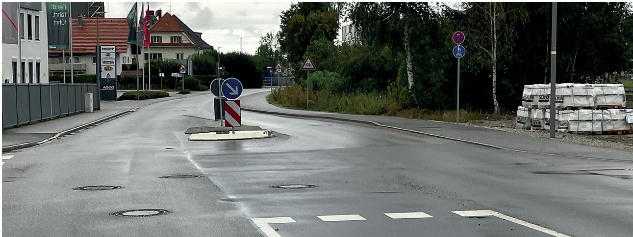
Der Gehweg links darf nicht mit dem Rad befahren werden. Rechts muss man auf dem Begleitweg radeln. Der wird kurz darauf zum Gehweg und man muss auf die Straße wechseln. So birgt die neu gestaltete Johann-Georg-Fendt Straße viele Missverständnisse und Gefahren.
