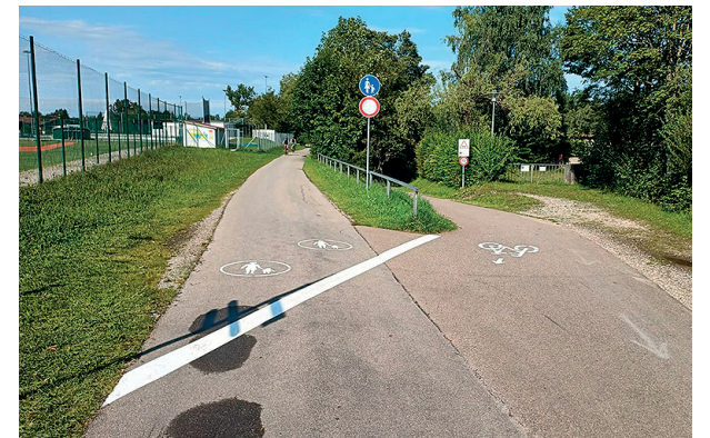
Der Lechuferweg ist seit dem Sommer nur noch für Fußgänger:innen freigegeben. Mit dem Rad wird man auf neue Wege in die Stadt und durchs Weidach geleitet. Foto: Johannes Ott
