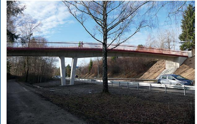
Der Neubau kommt ohne Mittelpfeiler aus und ist deutlich breiter als die alte Brücke.
