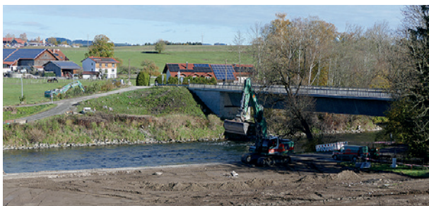
Oben ist der westliche Teil der Umleitung für Radler zu sehen. Die neue Brücke wird westlich der alten verlaufen (Foto unten).
