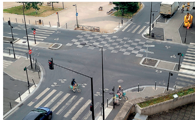
Geschützte Kreuzung: Unkomplizierte Lösungen – eine Kreuzung mit „holländischem Charakter“. Vorbild für Kempten?
