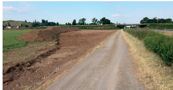
Das Baufeld der neuen Anschlussstelle bei Altdorf/Biessenhofen südlich der B12.
